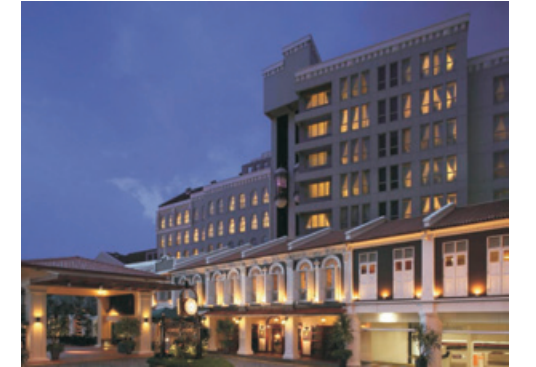
新加坡悦乐雅柏酒店 Existing Village Hotel Albert Court
